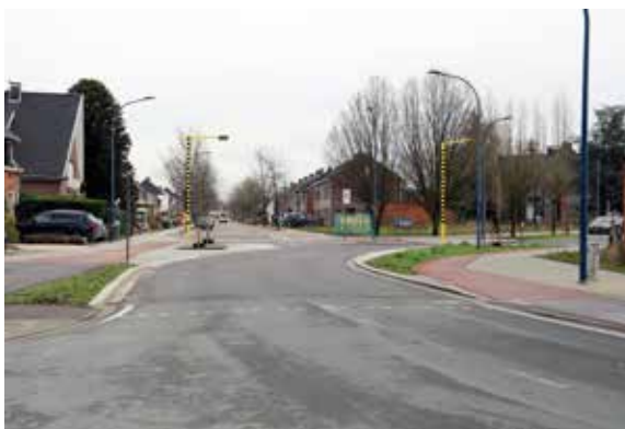
▲ Het vernieuwde fietspad in de Ooststatiestraat vormt het sluitstuk van een veilige verbinding tussen Kontich-Centrum en het station.
