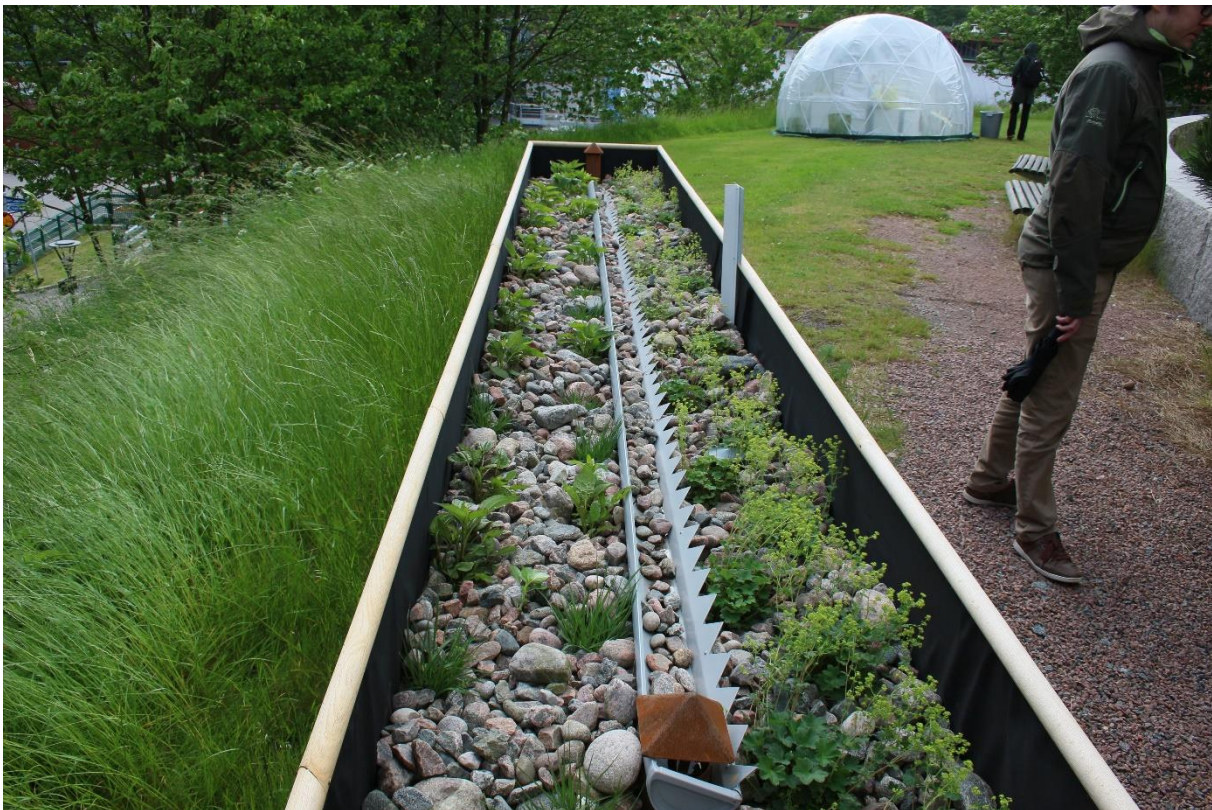
Figuur 32: pas aangelegde bovengrondse regentuin. De beplanting is nog niet volgroeit. Dit type wordt boven de grond geplaatst en is (in dit geval) niet water doorlatend. Het vertragend effect wordt bereikt door het water door verschillende grondsoorten te laten lopen en onderaan via een drainage leiding terug op te vangen. Bij hevige piekbuien kan er even water aan de oppervlakte komen te staan.
