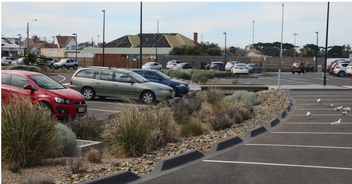
Figuur 30: Parking heraanlegd om water te laten afstromen naar stenige groenzone. De overloop is zichtbaar net onder de rode wagen. Buffering wordt gerealiseerd door water tijdelijk aan het oppervlak toe te laten. De begroeiing en de grote stenen zorgen voor versnelde indringing in de ondergrond.
