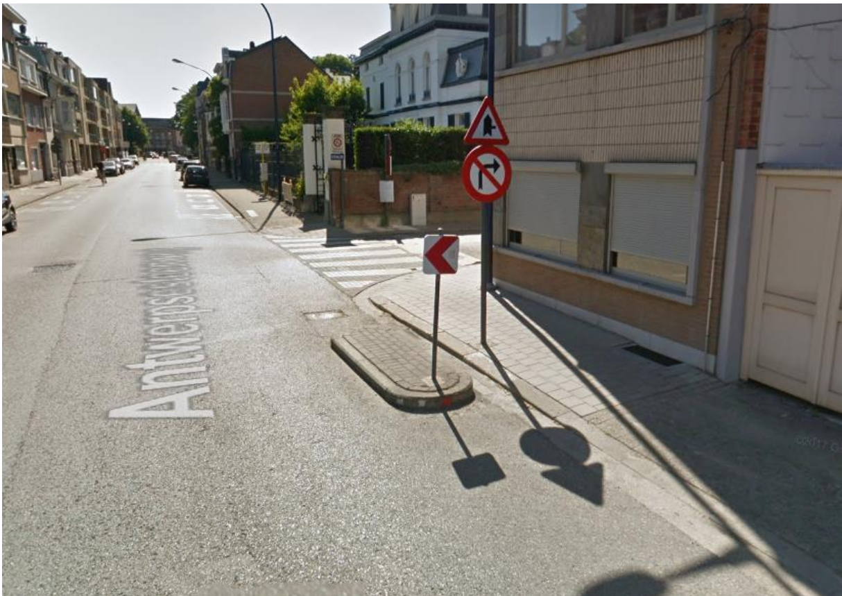
Figuur 29: Verkeersbegeleidende ingreep met bordje en verhard verkeerseiland: het eiland heeft een vreemde vorm vermoedelijk om de afstroming door de goot niet te verstoren. Deze situatie had ook opgelost kunnen worden door
