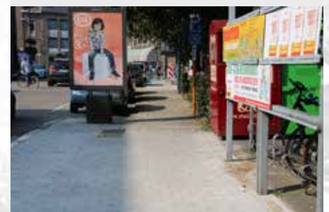
Heraanlegd voetpad aan Gemeentepark
